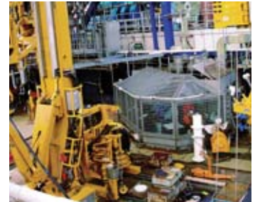
グループの努力の結晶ともいえる掘削システムの機器が並ぶドリルフロア。
