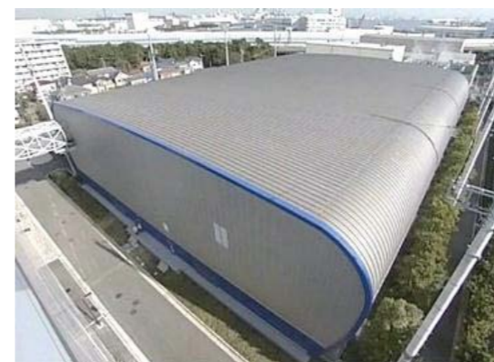
Fig.26 地球シミュレータ棟 (横浜市金沢区 JAMSTEC 横浜研究所)
