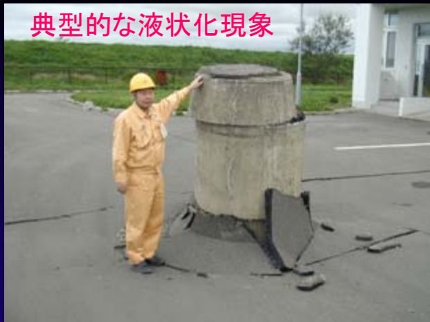
浮上したマンホール, 2003/9/26 (十勝沖地震)
