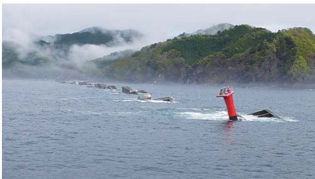
津波により決壊・破損した釜石港湾口防波堤の様子 — RIGC 提供 —
