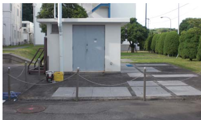
【中和処理装置機械室】
