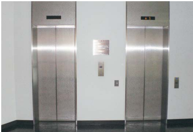
エレベーターの片側運転
