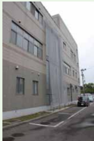
明り取り窓部に取り付けられた日よけ
