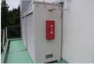
屋外に設置されたボンベ庫
