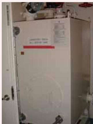
「ちきゅう」で発生した有害物質を含まない化学廃液をためておくケミカルバッファタンク。必要に応じて有害性の確認、pH 調整を行い、海洋中に放流する。
