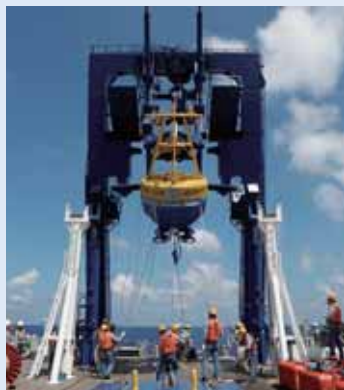
海洋地球研究船「みらい」船上におけるトライトンブイの設置作業
