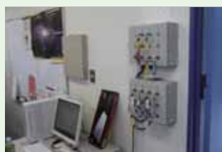
薬品・鍵管理システム
