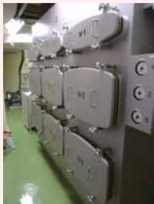
放射性物質を捕集するための フィルターユニット
