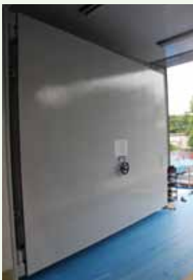
新保管庫に設置された津波対策用防水扉
