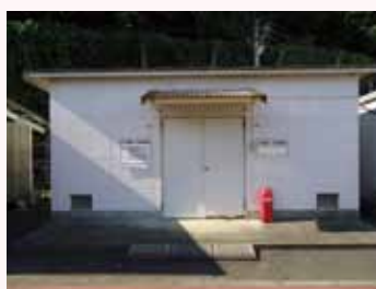
化学廃液一時保管庫(横須賀本部)
