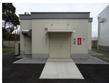
新しく横須賀本部に建設した生物サンプル庫
