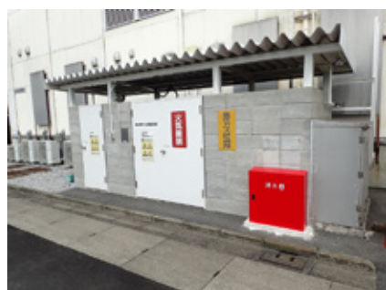
高圧ガスの容器置場
