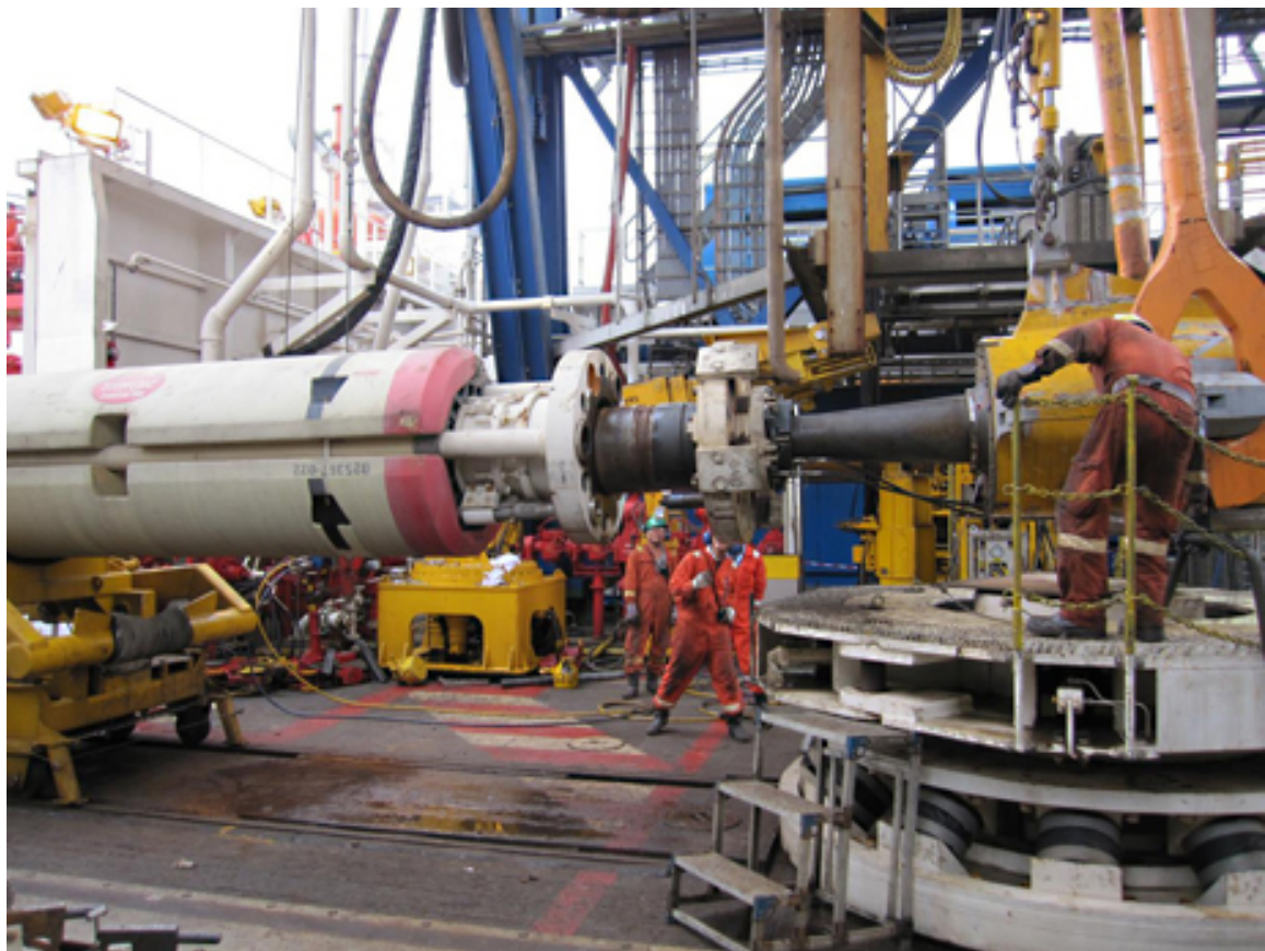
【写真1】ライザーパイプ降下作業の様子
