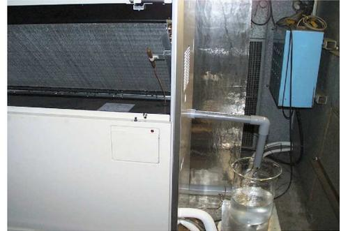
図5. 3. 3-1 空調設備兼用空気中水分回収装置
