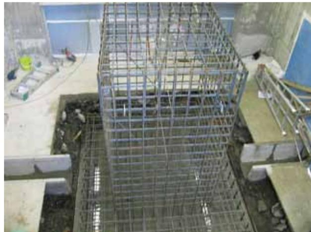
図2 NanoSIMS導入のためのピット内基礎工事。SIMS設置箇所の耐荷重及び制振性向上のため、独立基礎としました。
