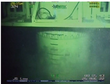
図3 集泥管が着底した瞬間
