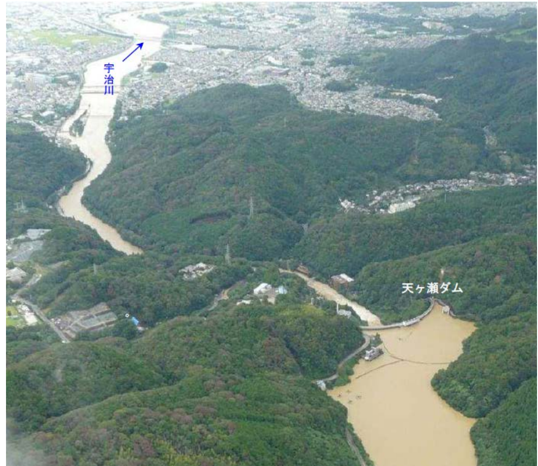
平成25年台風18号による淀川の洪水状況
