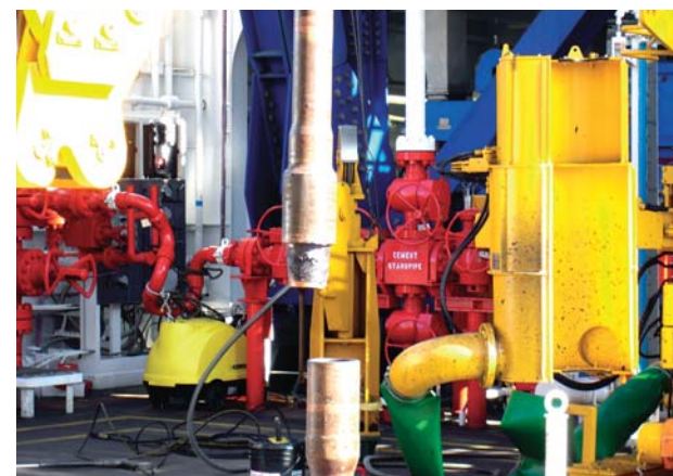
パイプの結合部分。位置をセットしたり、回転させて締める作業もすべて自動化されている。
