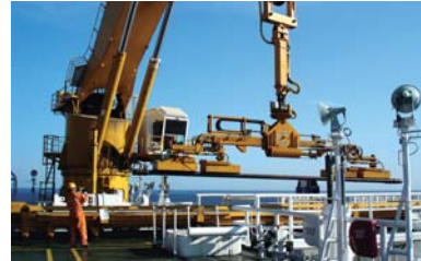
ドリルパイプは、クレーンで持ち上げ、パイプトランスファーシステムに移される。
