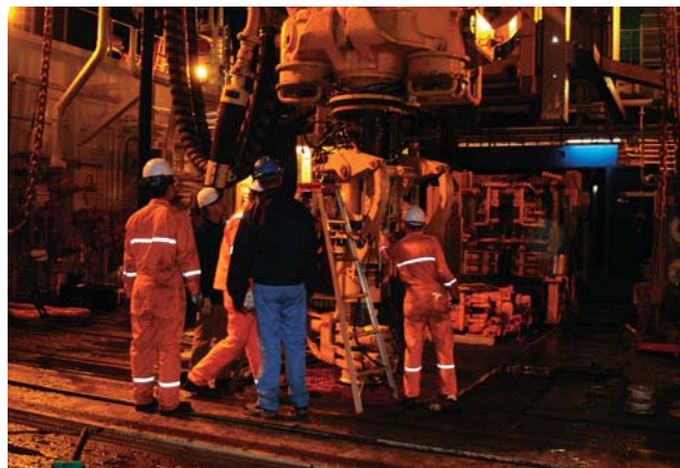
陽が落ちて作業は続く。試験運用では12時間だったが、本番では24時間体制で掘削が行われる。
