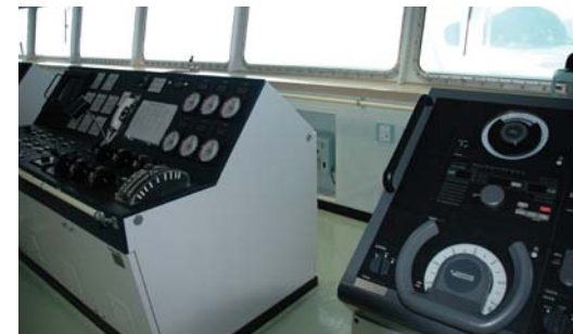
試験運用では掘削作業とともに、DPS操作訓練など操船に関する試験や訓練も実施された。
