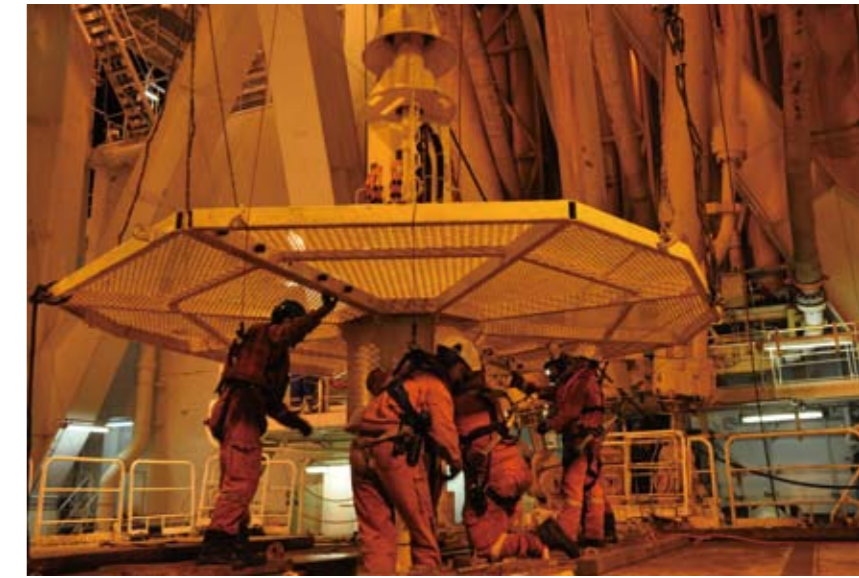
長期孔内観測装置を設置した掘削孔の孔口部分に置かれるROVプラットフォームとコネクター部。プラットフォームの直径は約5m。
