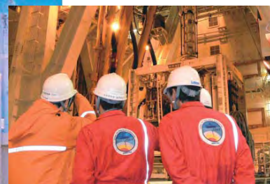
船上に回収した上部BOPの 状況を見守るスタッフ
