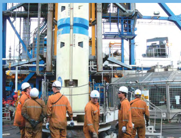
ライザーパイプの接続作業を行うドリルフロアの様子
