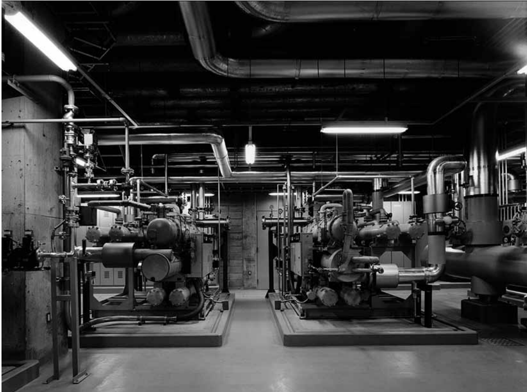
水冷式ウォータチリングユニット
