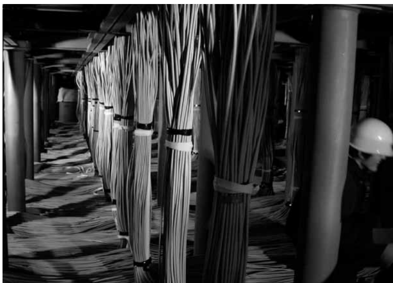
計算ノードと結合ネットワーク間のケーブル敷設作業の様子
