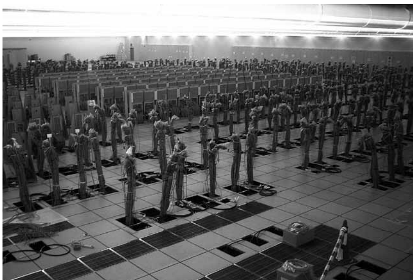
ケーブル敷設作業が完了したときの様子
