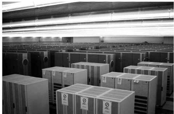
2001年12月末に全ての筐体の設置が完了した
