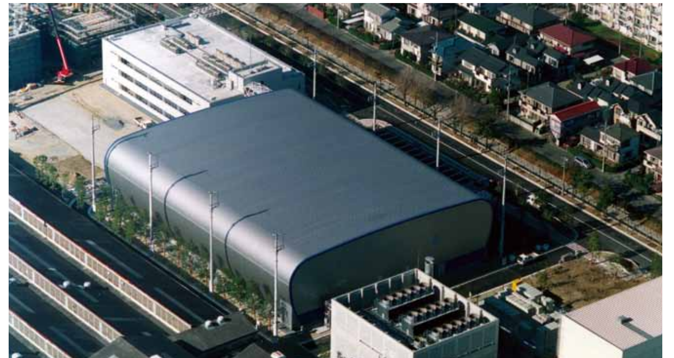
鉄骨2階建て3層構造の地球シミュレータ棟は、電磁ノイズを除去する照明システムをはじめ、外部からの電磁波を完全シールドするなど、さまざまな工夫が凝らされている。
