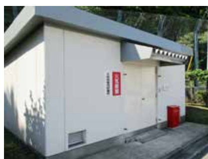
改修を行った危険物保管用の倉庫（危険物屋内貯蔵所）
