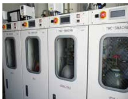
可燃性ガスや毒性のあるガスについては、シリンダーキャビネットに収納し、高圧ガスの安全を確保しています
