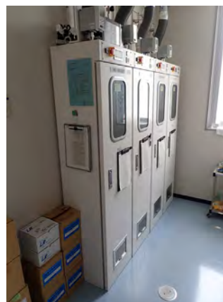
高圧ガスのうち可燃性や毒性等を有するガスを貯蔵するためのシリンダーキャビネット（横須賀本部）
