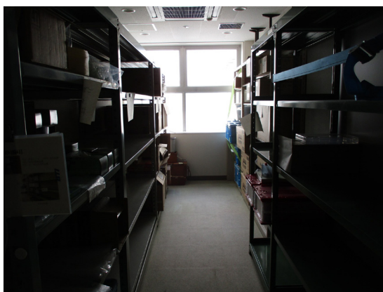
対策後：床や棚の荷物等の整理整頓及び突っ張り棒による耐震固定
