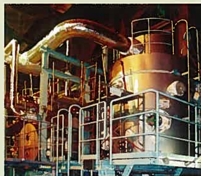
廃泥水処理装置 泥水を濃縮する装置
