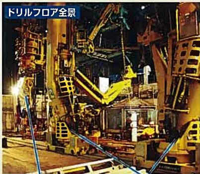
ドリルフロア全景 パワースイベル 降下したドリルパイプを回転させる
