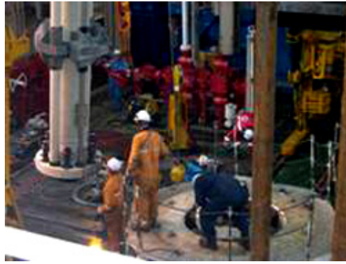
(写真2) ライザーパイプ接続の作業状況
