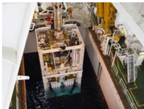
(写真-1) BOPを海底面に設置するため船上から降下させる様子
