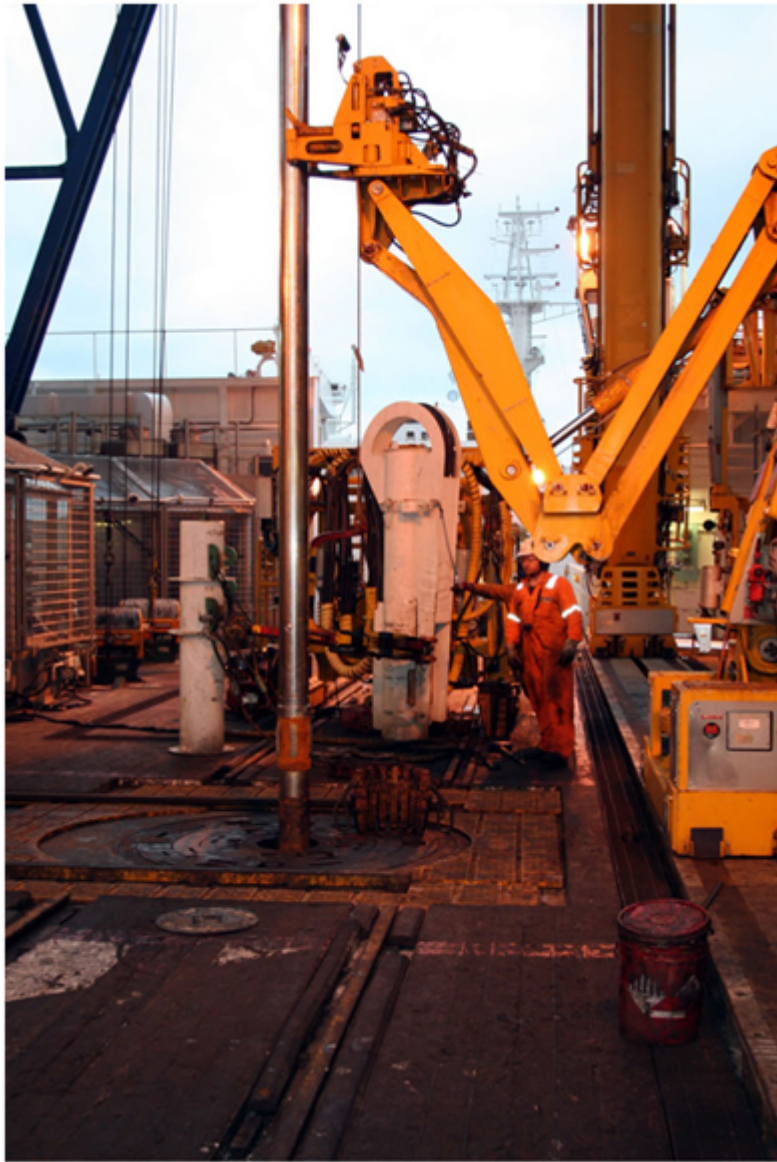
写真1：各種の物理計測センサーを搭載した掘削同時検層（LWD）ツールを降下する
