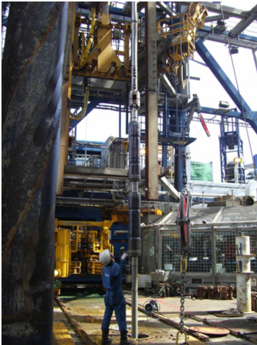
【写真1】孔内地殻応力・間隙水圧計測ツールを降下する様子
