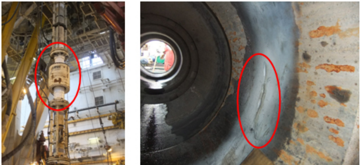
図1 損傷した機器（左）及び機器内部に生じたひび（右）
