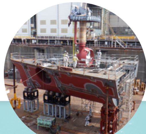
建造中の「みらいII」の様子 ©JAMSTEC/JMU
