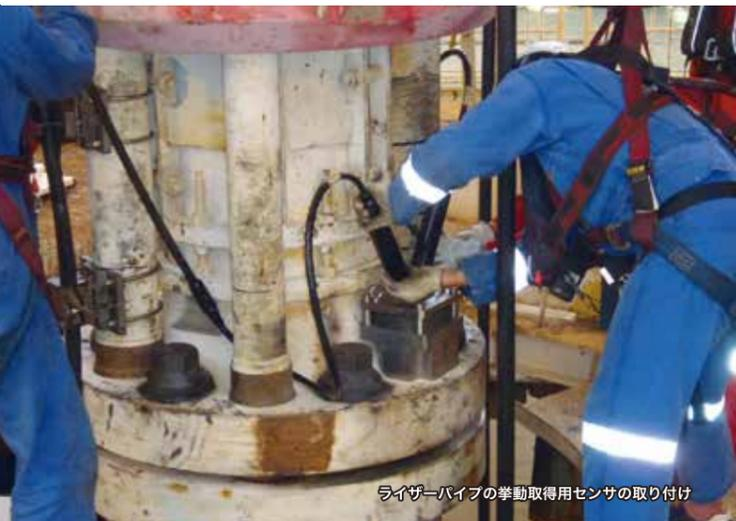
ライザーパイプの挙動取得用センサの取り付け
