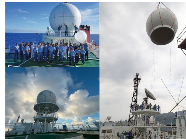
図17 レドームとアンテナ 左上：初代 (MR13-03航海時に撮影) 左下：2代目 (MR24-04航海時に撮影) 右：更新工事時、設置済みのパラボラアンテナにレドームを被せる直前 (2014年5月撮影)
