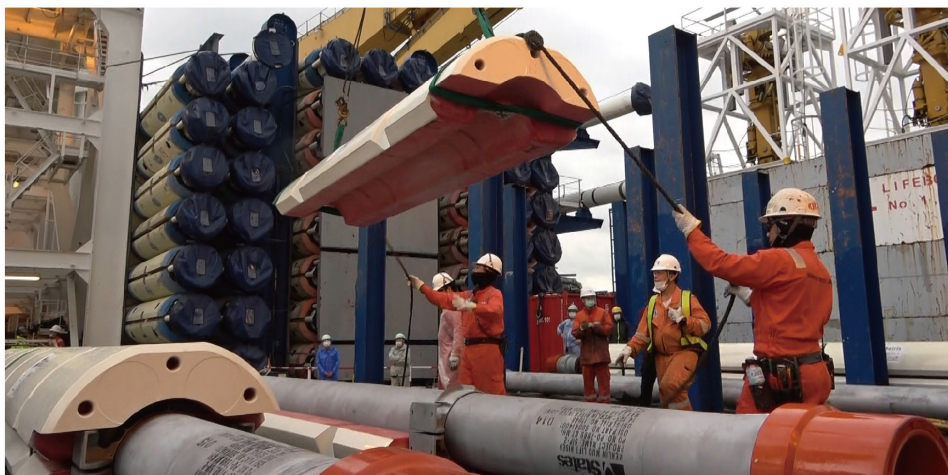
Merlinライザーへの浮力体取り付け作業
