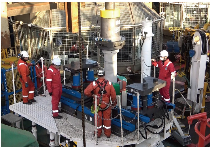
Merlinライザーハンドリング確認
