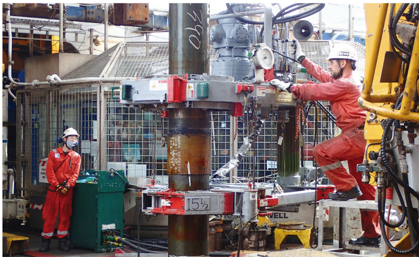
図2 VAM21 ケーシングライザーの芯をあわせ、ねじ込んでいるところ
