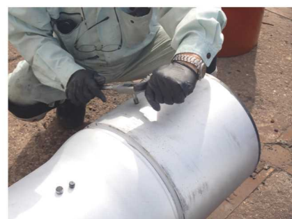
揚泥管の油圧ポート用ネジの確認
