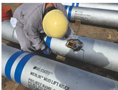
超音波厚さ計による揚泥管の肉厚測定
