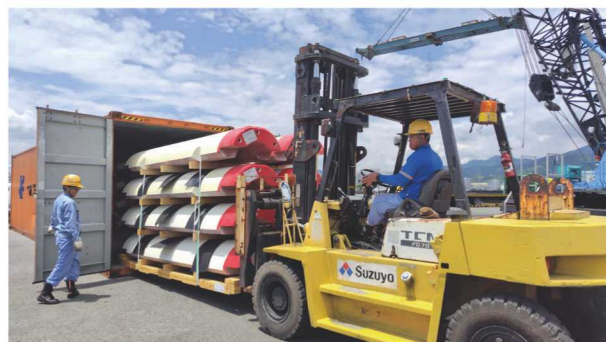
浮力体の輸送用コンテナからの取り出し
