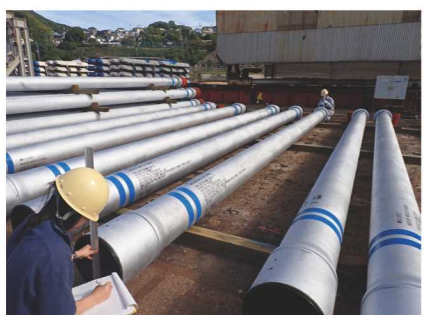
レーザー距離計による揚泥管の長さ測定
